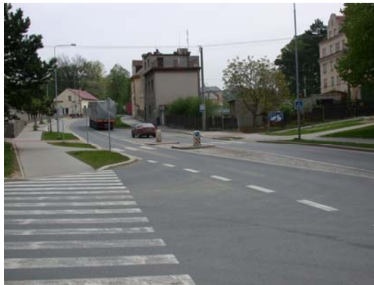
Obr. 6 – Úprava průtahu (Dobřany)
