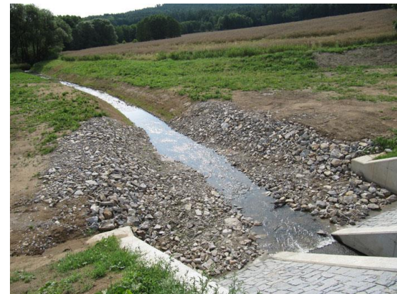
Oprava poldru Cehnice
