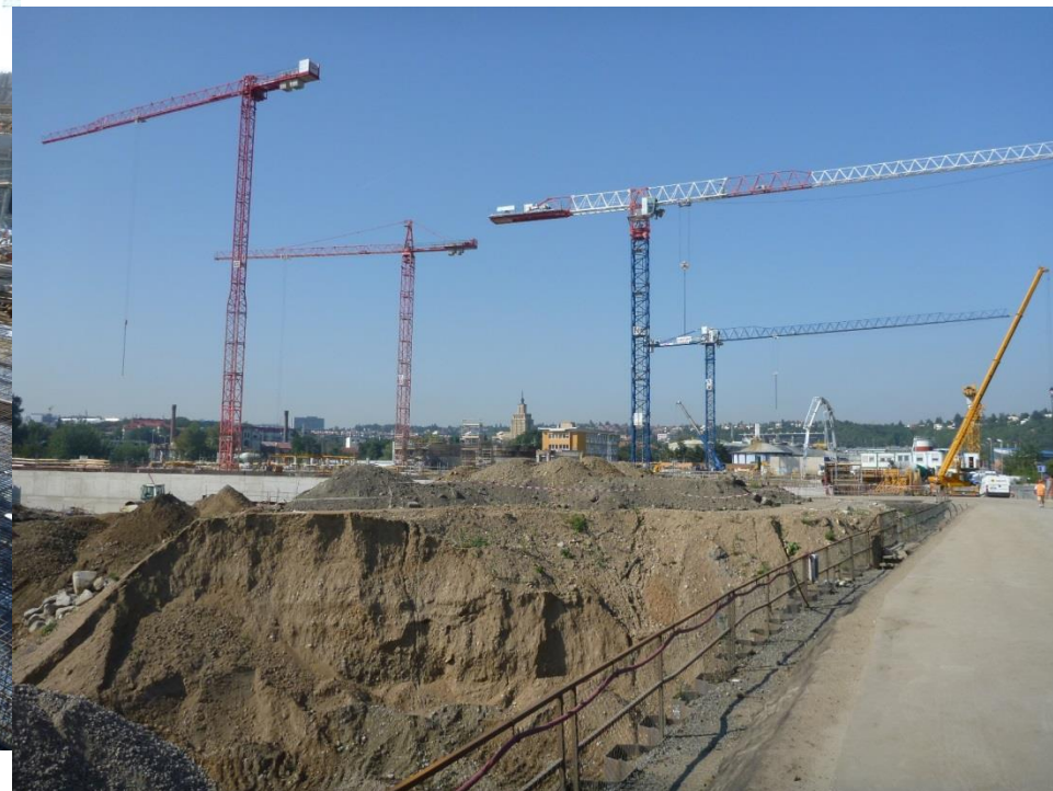
Pohled stavbou NVL na jejím počátku
