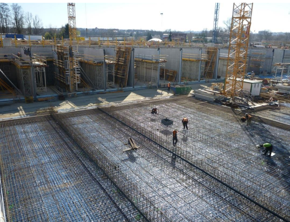
Armovací práce - dosazovací nádrže
